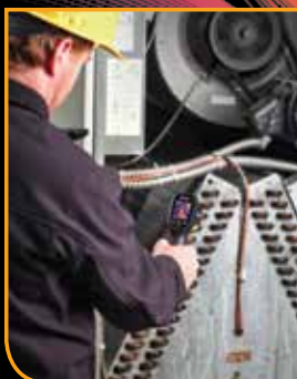
Проверка системы отопления
